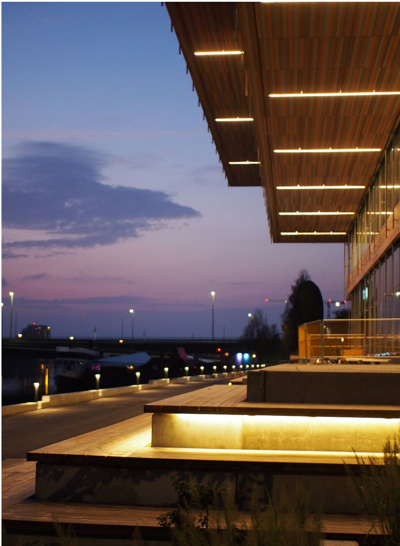
WSP Umeå (armaturena i skärmtaket).
