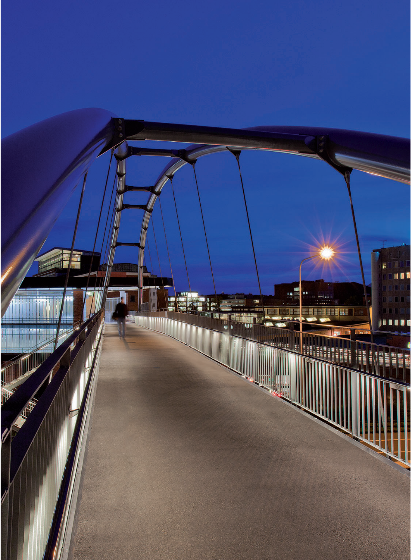
Sickla gångbro, Stockholm.
